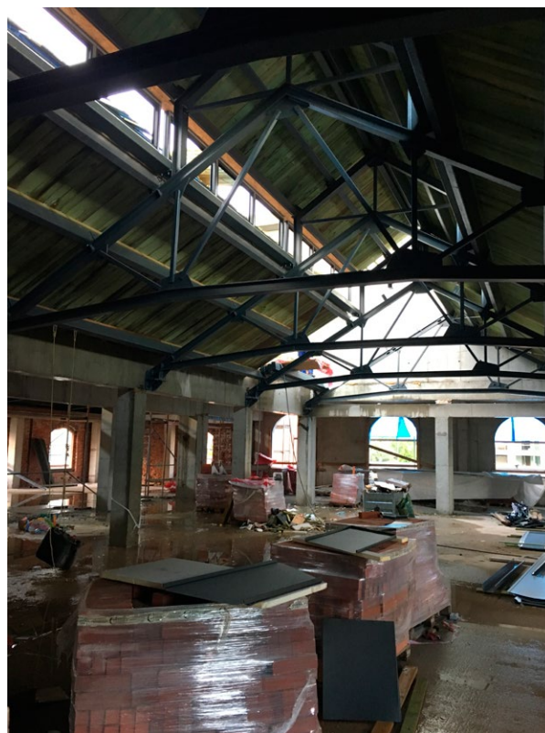
Fig. 8. Second floor interior of the lower part of the plant, visible reconstructed steel structure of the roof; photo by P. Marciniak Ryc. 8. Wnętrze drugiego piętra niższej części zakładu, widoczna zrekonstruowana stalowa konstrukcja dachu; fot. P. Marciniak.
