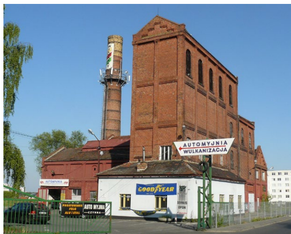
Fig. 4. Incineration Plant, image from 2007 showing the missing smokestack top and the additions on the ground level; photo courtesy of Litoborski+Marciniak. Ryc. 4. Spalarnia, zdjęcie z roku 2007 ukazujące brakujący czubek komina oraz dobudówki na poziomie parteru; fotografia dzięki uprzejmości Litoborski+Marciniak.
